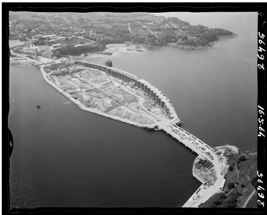
Figure 27 : Négatif sur film : Vue aérienne du barrage de la Rance reliant Saint-Malo à Dinard. La vue est prise entre les deux rives durant les travaux (photographie datant du 16 mai 1964, Créations Artistiques Heurtier (Photographe), extraite des collections en partage du Musée de Bretagne)
