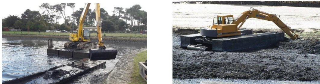
Figure 34 : pelle mécanique sur ponton flottant (à gauche) et pelle amphibie (à droite) (EGIS et IDRA, 2019)
