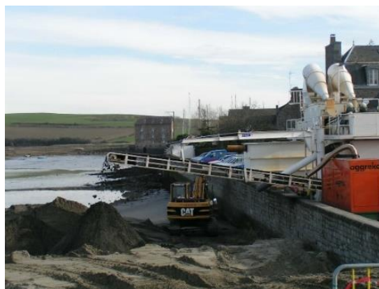
Figure 38 : Photographies de l'unité de dessablage/criblage (EDF, 2003)
