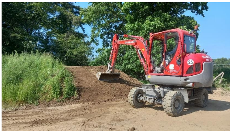
Figure 55- Construction d'une digue à base des sédiments de l'estuaire de la Rance dans le cadre du projet SURICATES
