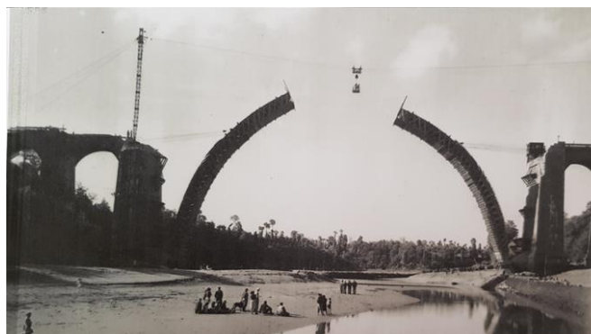
Figure 11 : Photographie ancienne montrant un fond sédimentaire probablement sableux au niveau du pont de Lessart, en cours de reconstruction vers 1950 (photo aimablement transmise par L. Delahaie, extrait du rapport diagnostic « Fonctionnement hydro-sédimentaire du bassin maritime de la Rance » du Conseil Scientifique, 2023).
