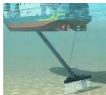
Figure 37 : Dragage par injection d'eau sous pression
