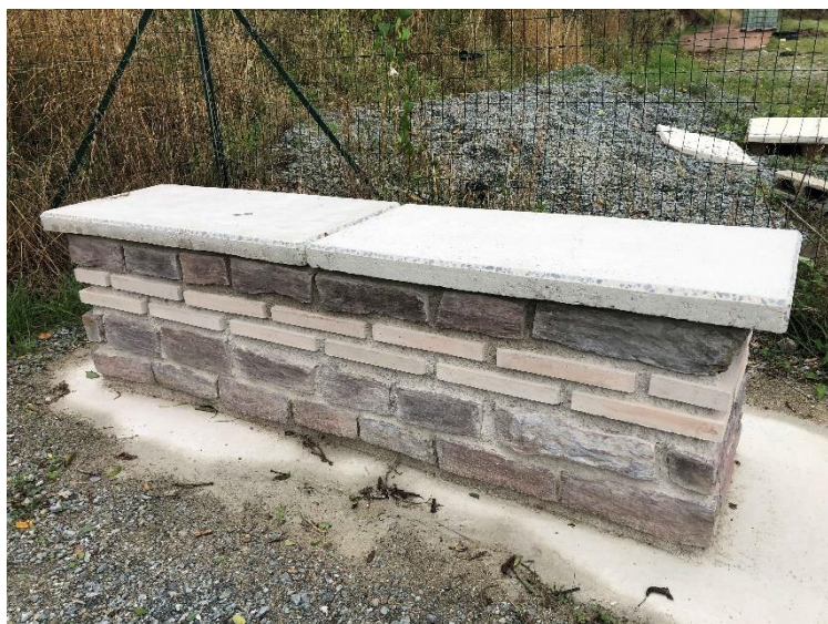
Figure 53- Muret en béton à base de sédiments construit dans le cadre du projet SUIRCATES
