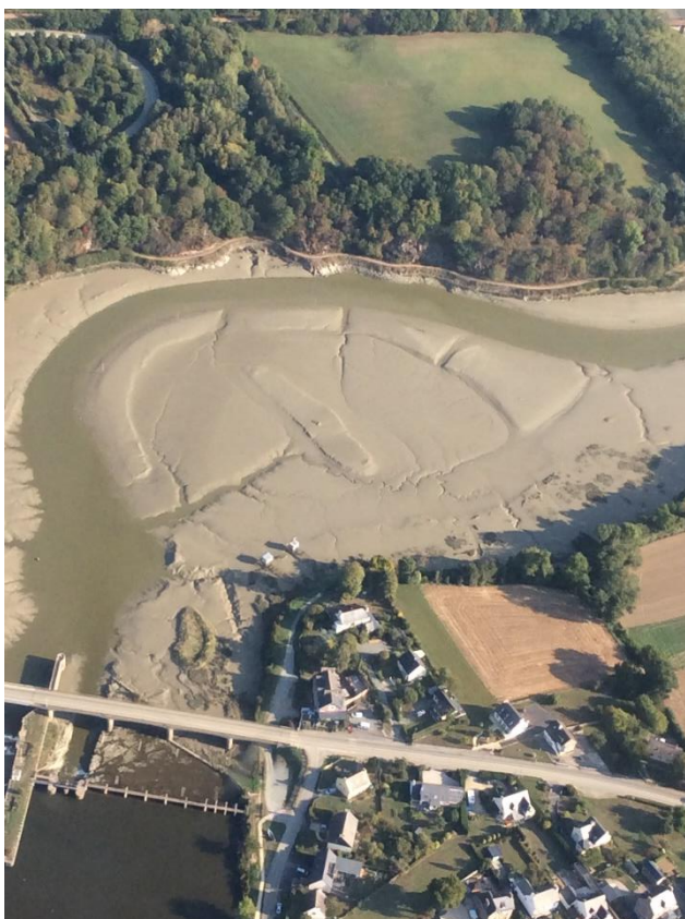
Figure 28 : Vue aérienne du piège du Lyvet en aval immédiat de l'écluse du Châtelier, (photographie de A tire d'ailes, 2022)
