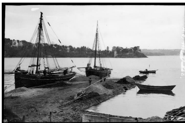
Figure 22 : Négatif sur film Pleudihen-sur-Rance : vue de la cale de Mordreuc en construction avec des voiliers et barques amarrés, première moitié du 20 ème siècle (photographie de Laurent-Nel Henri, extraite des collections en partage du Musée de Bretagne).
