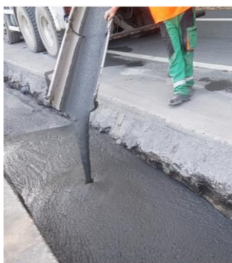
Figure 56 : Coulis autocompactant à gauche (projet SEDIMEL) et granulats légers développés par l'entreprise Alteo environnement Gardanne à droite
