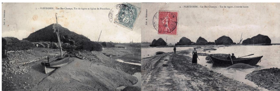
Figure 20 : Cartes postales anciennes Les Bas-Champs : à gauche, vue sur une gabarre reposant dans la souille de Monsieur Desvaux derrière laquelle s'entassent des fagots, à droite, terrain au niveau des Bas-Champs occupé collectivement par les tas de fagots et les gabares (sources : Courtois, 1995 ; Motte, 2017)
